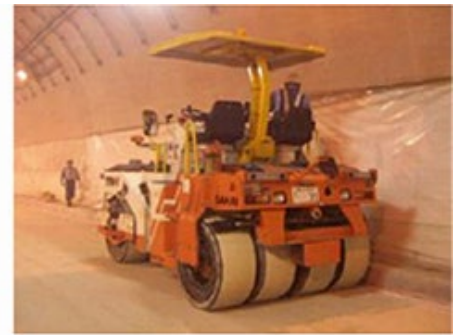
トンネル内舗装施工例
