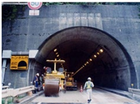
トンネル内舗装施工例
