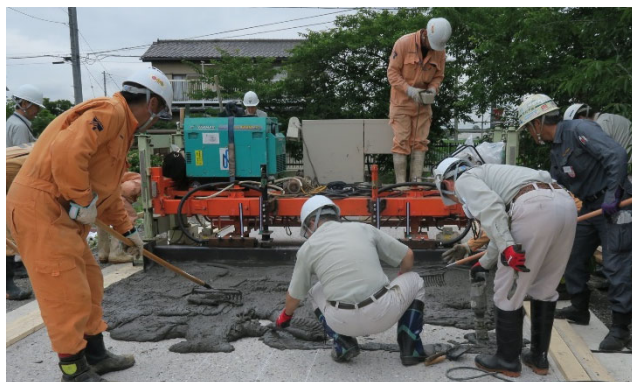
試験施工状況（厚さ4cm）
