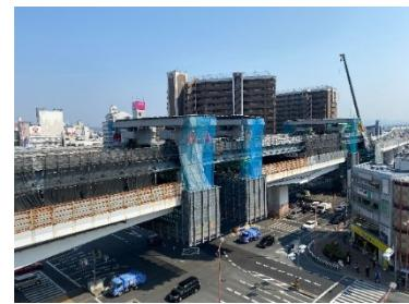
生活環境への影響を最小限にすることで昼夜での作業が可能となりました。本工事の例では、既設コンクリート橋梁の撤去、新設鋼製橋梁の架設を含めて約3年で工事を完了することができました。
