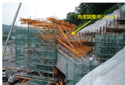
可変式アーチ移動作業車
