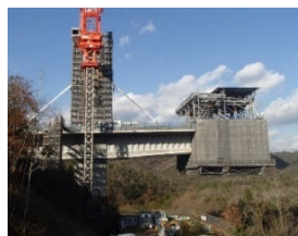
超大型移動作業車施工状況（生野大橋）
