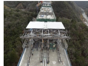
超大型移動作業車施工状況（生野大橋）
