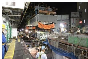
京王下北沢駅付近橋梁の架設状況 (中空ホロー桁-鉄道橋)
