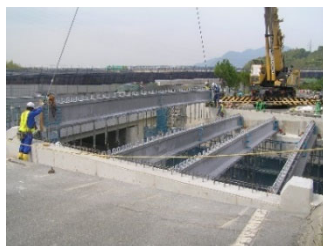
北九州JCT堀越Cランプ橋の架設状況 (I桁-道路橋)
