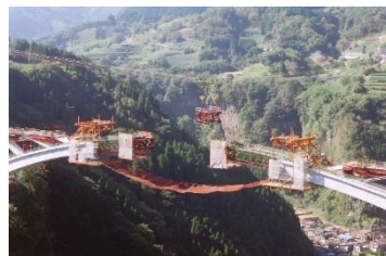
天翔大橋施工状況(トラス・メラン併用工法)
