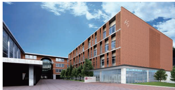
金沢学院大学附属中学・高校校舎棟増築工事 (石川県金沢市) 発注者:学校法人金沢学院大学
