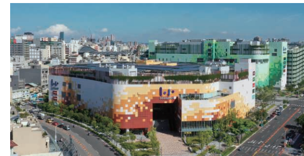
(仮称)三井ショッピングパークららぽーと台中新築工事 (台湾台中市) 発注者:三中東区啦啦寶都股份有限公司
