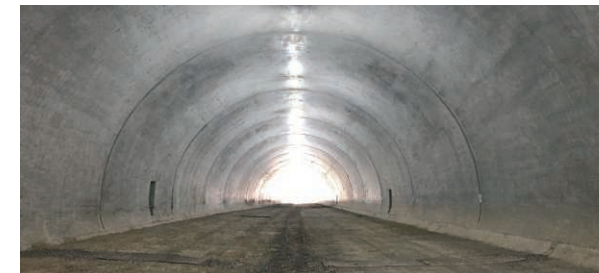
令和2年度木与防災木与第3トンネル工事 (山口県阿武郡) 発注者:中国地方整備局
