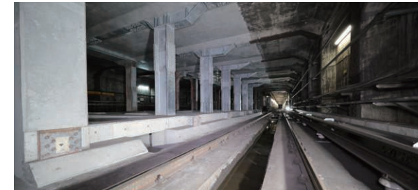
銀座線新橋駅改良土木工事 (東京都港区) 発注者:東京地下鉄株式会社
