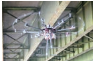
ドローンを用いた道路橋のひび割れ撮影状況
