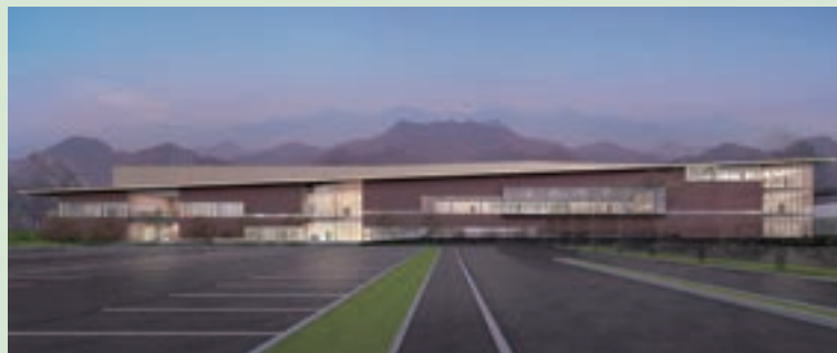
ハーモニック・ドライブ・システムズ有明工場新工場新築工事 (長野県安曇野市) 発注者: 株式会社ハーモニック・ドライブ・システムズ
