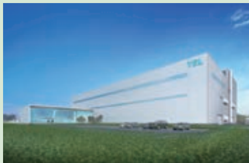
東京エレクトロン テクノロジーソリューションズ 東北事業所新棟新築工事 (岩手県奥州市) 発注者: 東京エレクトロン テクノロジーソリューションズ株式会社
