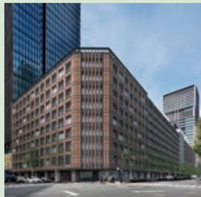
大手町ビル大規模リノベーション工事 (外装改修工事2F以上) (東京都千代田区) 発注者: 三菱地所株式会社
