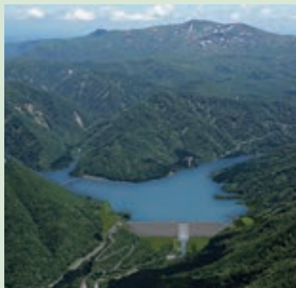
成瀬ダム原石山採取工事(第1期) (秋田県雄勝郡) 発注者: 国土交通省 東北地方整備局
