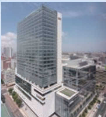
札幌創世1.1.1区北1西1地区第一種 市街地再開発事業施設建築物新築工事 及び公共施設整備工事 (札幌市中央区) 発注者: 札幌創世1.1.1区北1西1地区 市街地再開発組合
