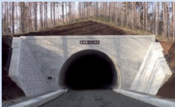
一般国道340号(仮称)大峠トンネル築造工事 (岩手県宮古市～岩手県遠野市) 発注者: 岩手県
