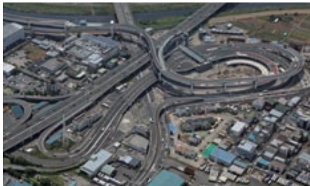
(高負) 高速横浜環状北西線 港北ジャンクション他下部・基礎・街路築造工事 (神奈川県横浜市) 発注者: 首都高速道路株式会社
