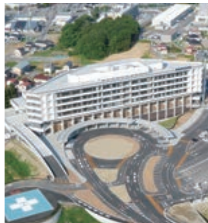
気仙沼市立新病院建設工事 (宮城県気仙沼市) 発注者: 気仙沼市
