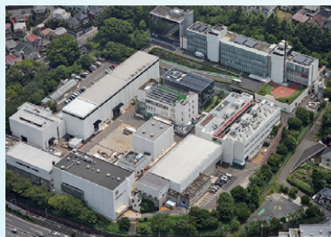
大成建設技術センター（神奈川県横浜市）
