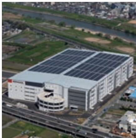
レッドウッド藤井寺 ディストリビューションセンター新築工事 (大阪府藤井寺市) 発注者: RW4特定目的会社
