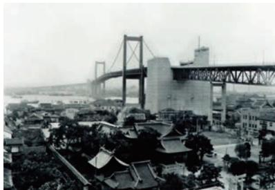
① 若戸大橋は、北九州市を横断する国道199号のうち、洞海湾に架設された吊橋を含む、延長約2.1kmの一般有料道路だ。建設当初あった歩道は交通量の増大で廃止され、4車線に拡幅された。写真は当社が施工した若松側から見た施工当時の風景
