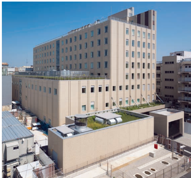
▲ 日本医科大学付属病院新築工事【I期工事】 (東京都) 発注者: (学)日本医科大学
