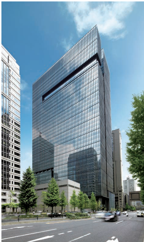
▲ (仮称) 大手町1-6計画のうち、 敷地内本体工事 (東京都) 発注者: みずほ信託銀行(株)
