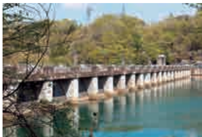
ダム湖側の左岸から見た堤体
