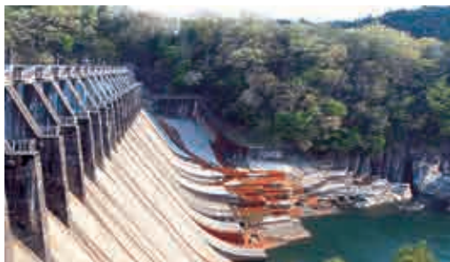
ラジアルゲート21門が並び壮麗な堤体。骨材の鉄分が生む朱色に彩られた左岸の減勢工のかたちもユニーク
