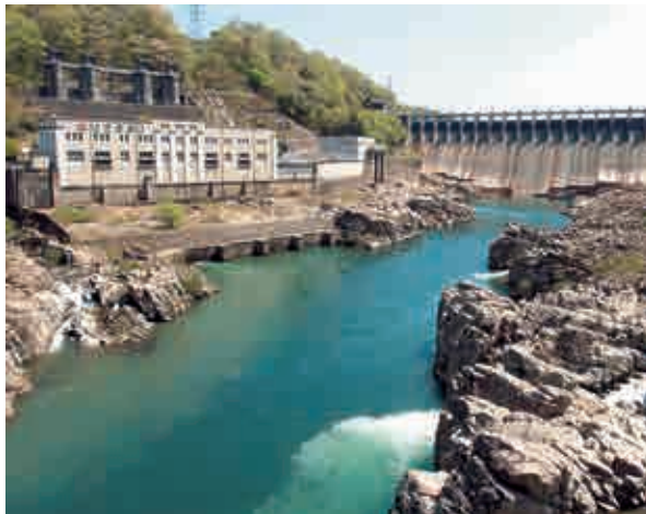
下流から大井ダムと大井発電所を望む
