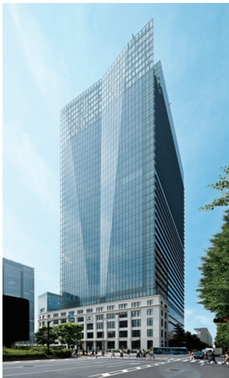
▲丸の内2丁目計画（仮称）新築工事 （東京都） 発注者:日本郵便(株)
