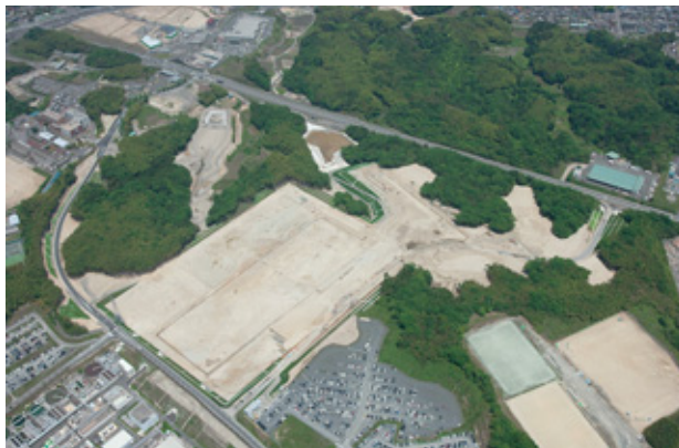
▲ 四日市新工場敷地造成工事 (三重県) 発注者: (株)東芝
