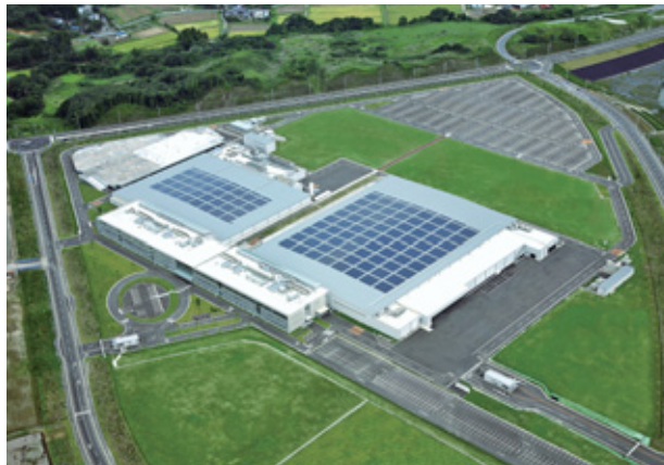
東京エレクトロン宮城株式会社本社工場新築工事 ▶ (宮城県) 発注者: 東京エレクトロン宮城(株)
