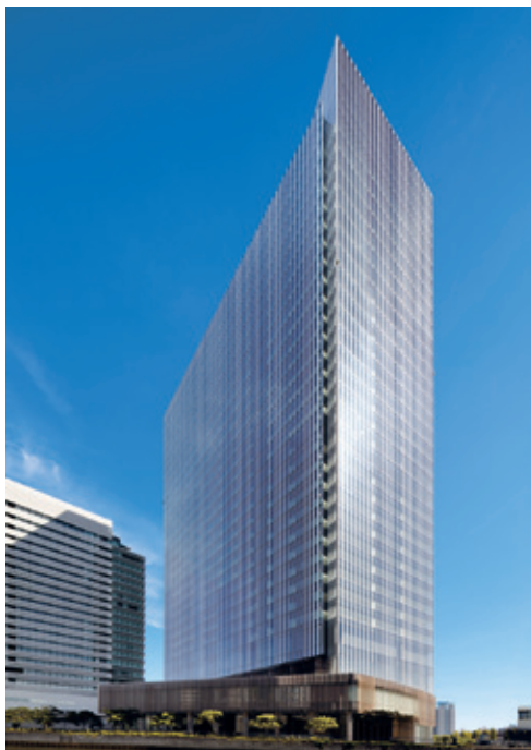
▲横浜三井ビルディング新築工事 (神奈川県) 発注者:三井不動産(株)
