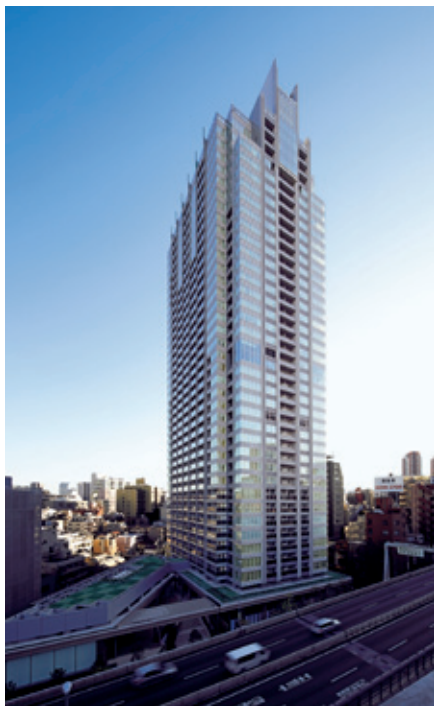
◀ 六本木三丁目地区第一種市街地再開発事業 施設建築物等新築工事 (東京都) 発注者:六本木三丁目地区市街地再開発組合
