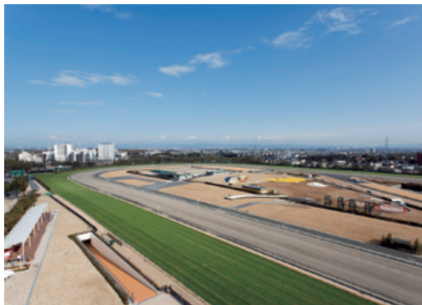
▲ 中京競馬場馬場改造その他工事 (愛知県) 発注者:名古屋競馬(株)・日本中央競馬会
