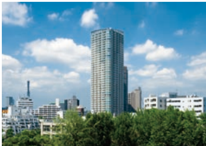
▲赤坂四丁目薬研坂南地区第一種市街地再開発事業 施設建築物新築工事 (東京都) 赤坂四丁目薬研坂南地区市街地再開発組合
