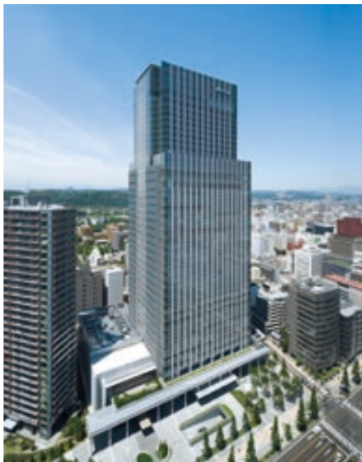
▲仙台トラストタワー新築工事 (宮城県) 森トラスト(株)
