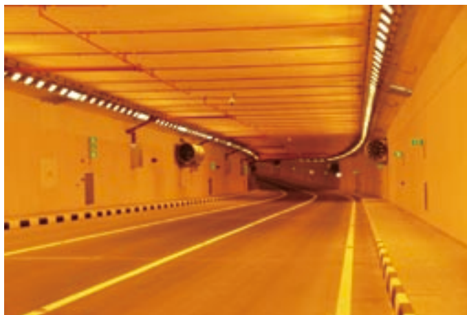
アラブ首長国連邦 ヤス島南トンネル工事▶ (アラブ首長国連邦) アルダール社
