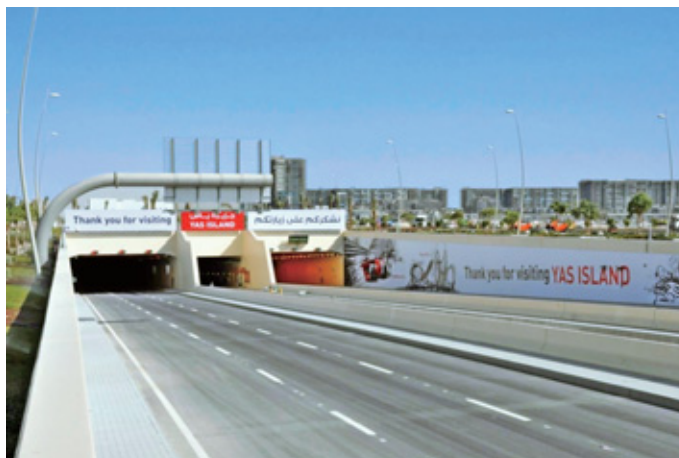
アラブ首長国連邦 ヤス島南トンネル工事▶ (アラブ首長国連邦) 発注者:アルダール社
