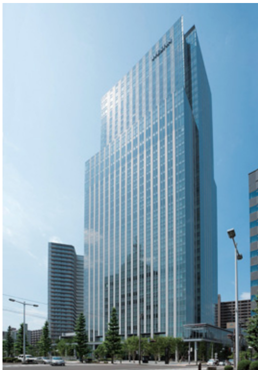
▲仙台トラストタワー新築工事 (宮城県) 発注者:森トラスト(株)
