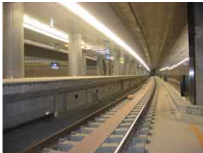
中之島新線建設工事のうち土木工事(第3工区)▶ (大阪府) 発注者:中之島高速鉄道(株)
