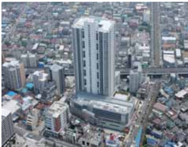
▲金町六丁目地区第一種市街地再開発事業 施設建築物等建設工事 (東京都) 発注者:金町六丁目地区市街地再開発組合
