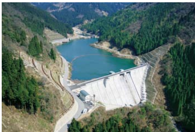
◀ 浄土寺川ダム事業 浄土寺川ダム建設工事 (ダム本体工事) (福井県) 発注者:福井県
