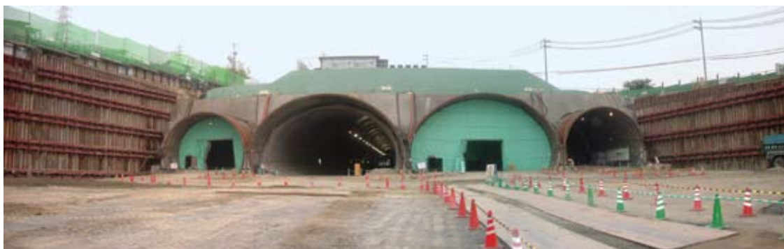
▲第二京阪道路小路トンネル工事 (大阪府) 発注者:西日本高速道路(株) 関西支社 ※当工事は、第二京阪道路小路トンネル(その2)工事を受注し、現在引き続き施工中です。
