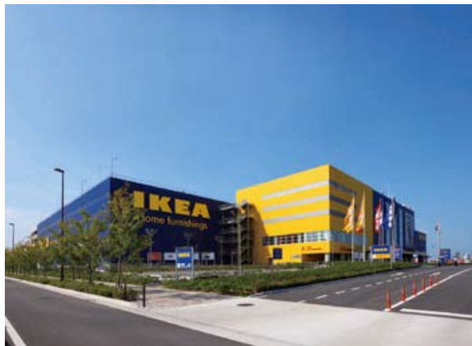
▲(仮称) イケア鶴浜新築工事 (大阪府) 発注者:IKEA Property,S.L. 日本支社
