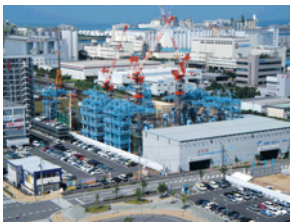
中央雨水ポンプ場建設工事 (千葉県千葉市)
