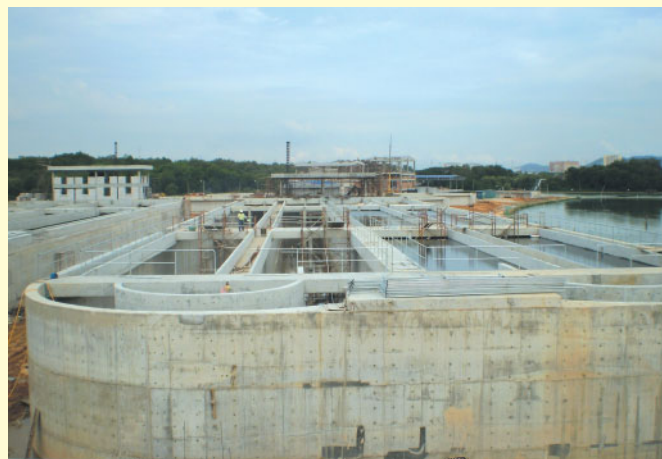
マレーシア 北部地域下水処理場建設工事 (その2) (マレーシア)
