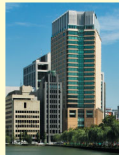
(仮称)ザ・ペニンシュラ東京新築工事 (東京都千代田区) 三菱地所(株)・(株)ペニンシュラ東京
