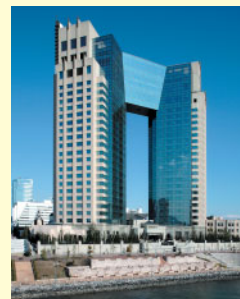
東京ベイコート倶楽部 ホテル&スパリゾート新築工事 (東京都江東区) リゾートトラスト(株)
