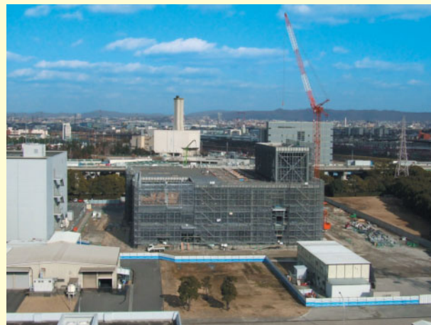
塩野義製薬(株)摂津新固形剤包装棟(208棟) 建設工事 (大阪府摂津市)
