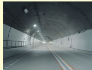
東北北陸自動車道 飛騨トンネル(その4)工事 (岐阜県飛騨市~大野郡) 中日本高速道路(株)
