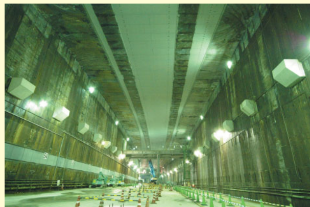
首都高速道路(株)(高負)KJ124工区(4)~KJ132工区(1) トンネル(その2)工事 (神奈川県川崎市)
