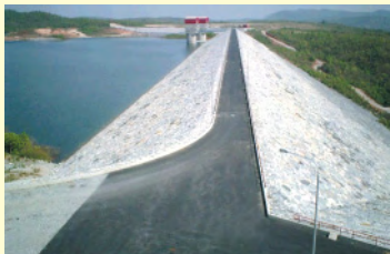
インド プルリア揚水発電所建設工事 (インド) 西ベンガル州電力公社
