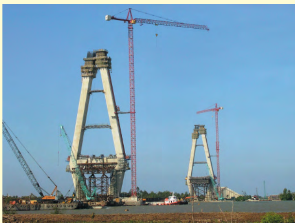
カントー橋建設工事 (ベトナム社会主義共和国)
