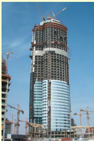
アルマスタワー新築工事 (アラブ首長国連邦)
