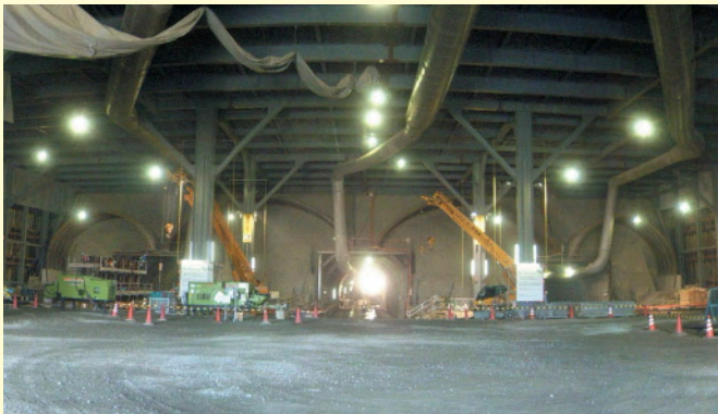
第二京阪道路小路トンネル工事 (大阪府寝屋川市)
