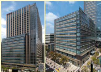
(仮称) 東京ミッドタウンプロジェクト (B・E棟) 新築工事 (東京都港区) アール・ピー・ベータ特定目的会社 他9社
