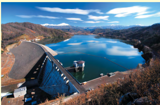
忠別ダム建設事業の内 フィル堤体建設第5期工事 (北海道上川郡) 北海道開発局旭川開発建設部
