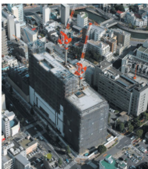
千葉中央第六地区 第一種市街地再開発事業 建設工事 (千葉県千葉市)
