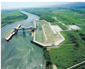
篠津中央二期農業水利事業 石狩川頭首工第2期建設工事 (北海道樺戸郡)
