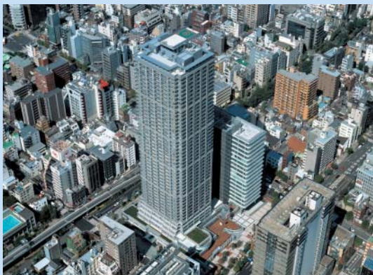
日本橋浜町三丁目西部地区第一種市街地再開発事業 施設建築物建設工事(住宅棟) (東京都中央区) 発注者:日本橋浜町三丁目西部地区市街地再開発組合
