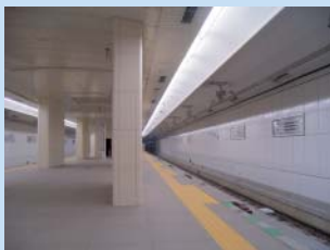
高速電気軌道第8号線 地下鉄線路および緑橋停留場工事（6工区） （大阪府大阪市） 発注者：大阪市交通局
