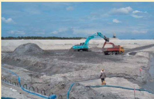
マレーシア ジマ石炭火力発電所建設工事 (マレーシア)
