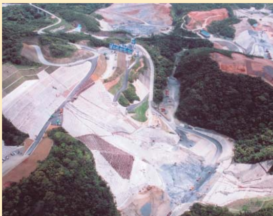
大保本ダム本体建設第一期工事 (沖縄県国頭郡)
