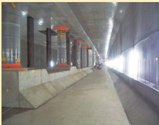
13号線新宿七丁目二工区土木工事 (東京都新宿区)
