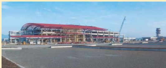
フィリピン イロイロ新空港建設工事 (フィリピン共和国)
