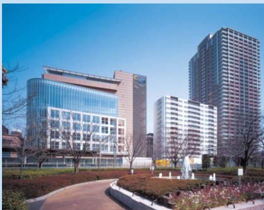
川口1丁目1番第一種市街地再開発事業 施設建築物等建設工事 (埼玉県川口市) 発注者:川口1丁目市街地再開発組合
