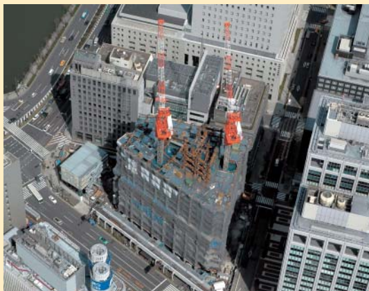
(仮称) ザ・ペニンシュラ東京新築工事 (東京都千代田区)
