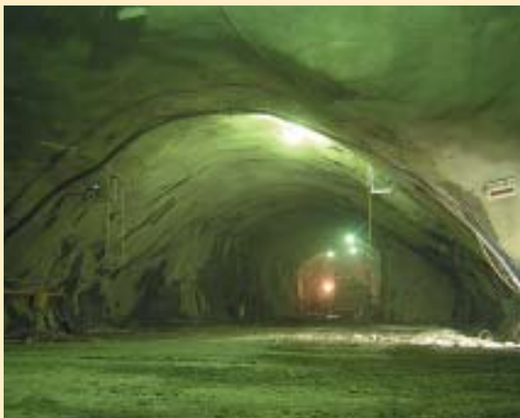
波方基地プロパン貯槽工事 (愛媛県今治市)
