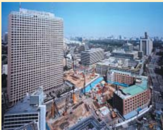
中央合同庁舎第7号館整備等事業建設工事 (東京都千代田区)
