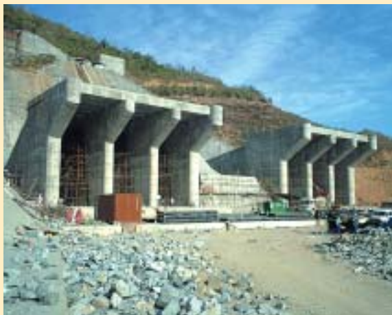
インド プルリア揚水発電所建設工事 (インド共和国)
