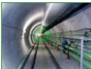
東西連係ガス導管新設工事 (東扇島)のうち土木工事(第2工区) (神奈川県川崎市)
