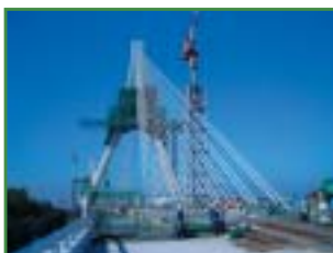
第二東名高速道路矢作川橋 (PC上部工) 東工事 (愛知県豊田市)
