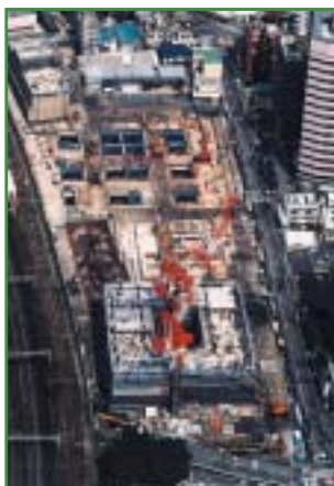
川口1丁目1番第一種市街地 再開発事業施設建築物等建設工事 (埼玉県川口市)
