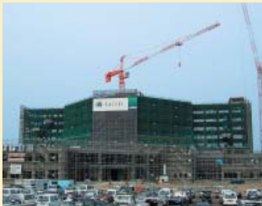
新潟県厚生農業協同組合連合会 長岡中央総合病院移転新築工事 (新潟県長岡市)
