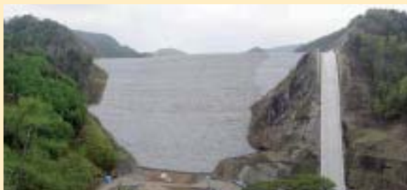
神流川発電所新設工事(1期)のうち 土木工事(上部ダム工区) (長野県南佐久郡)
