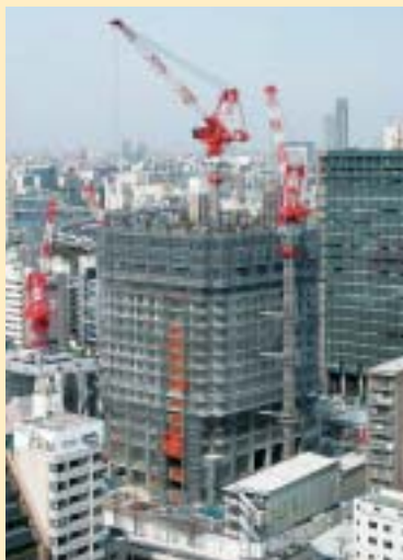
日本橋浜町三丁目西部地区第一種市街地 再開発事業施設建築物建設工事 (東京都中央区)
