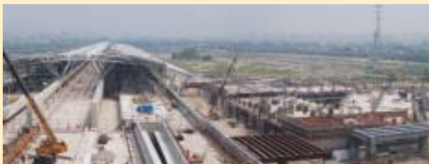
台湾高速鉄道台中駅舎建設工事 (台湾)
