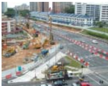
地下鉄MRT (C853工区) 建設
