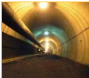
八王子城跡トンネル工事 (東京都八王子市)
