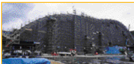
九州国立博物館(仮称) 新営工事(Ⅱ工区) (福岡県太宰府市)
