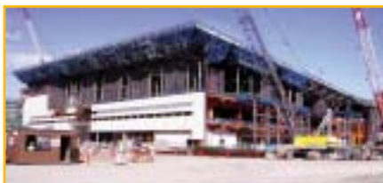
中部国際空港旅客 ターミナルビル 新築工事(その1) (愛知県常滑市)
