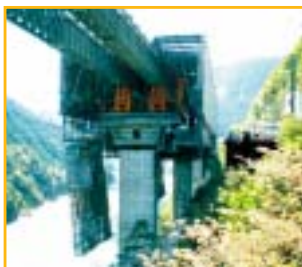
七色橋梁工事 (奈良県吉野郡)
