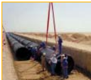
アラブ首長国連邦送水管工事 (アラブ首長国連邦)
