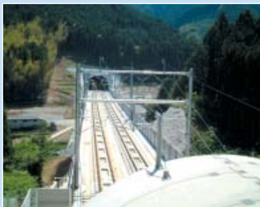
九州新幹線田上トンネル(北)その2工事 (熊本県八代郡)
