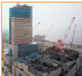
シンボルタワー(仮称) 建設工事 (香川県高松市)
