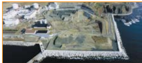
泊発電所3号機増設工事のうち土木準備工事 および関連除却工事(整地工区) (北海道古宇郡)
