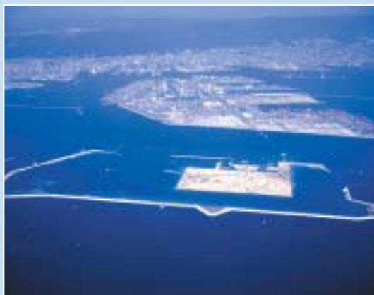
ポートアイランド沖護岸築造工事(その4) (兵庫県神戸市)
