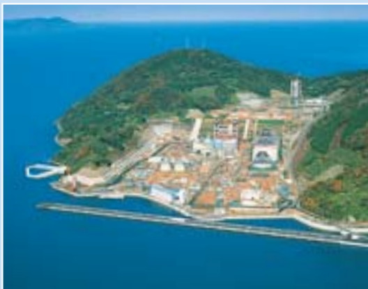
舞鶴発電所(京都府舞鶴市) 発注者・関西電力株式会社
