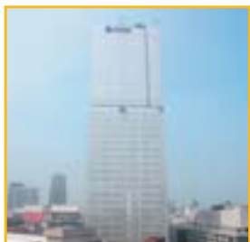
ブルデンシャルタワー [(仮称)永田町2丁目ビル計画] (東京都千代田区)
