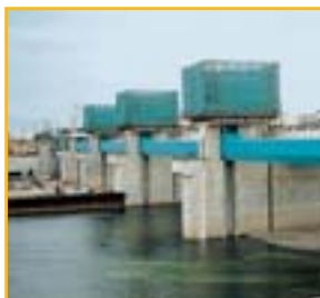
ろくぜきとうしゅこう 六堰頭首工建設工事 (埼玉県大里郡)
