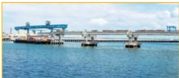
セブ南海岸道路橋梁工事 (フィリピン共和国セブ市)
