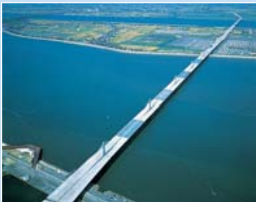
第二名神高速道路揖斐川橋 （三重県桑名郡長島町～桑名市） 発注者・日本道路公団中部支社
