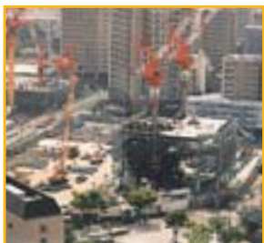
川崎駅西口地区第一種市街地 再開発事業施設 建築物業務棟建設工事 (神奈川県川崎市)
