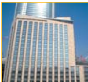
六本木六丁目地区第一種市街地 再開発事業に伴う B街区ホテル棟新築工事 (東京都港区)
