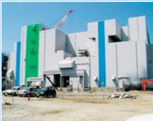
前処理建屋(青森県上北郡六ヶ所村) 発注者・日本原燃株式会社
