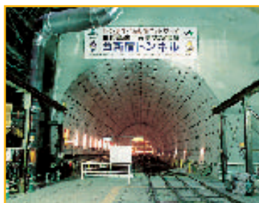
首都高速中央環状新宿線 西新宿トンネル工事 (東京都渋谷区)
