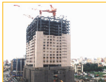
台南森園 りんえん 大飯店新築工事 (台湾)
