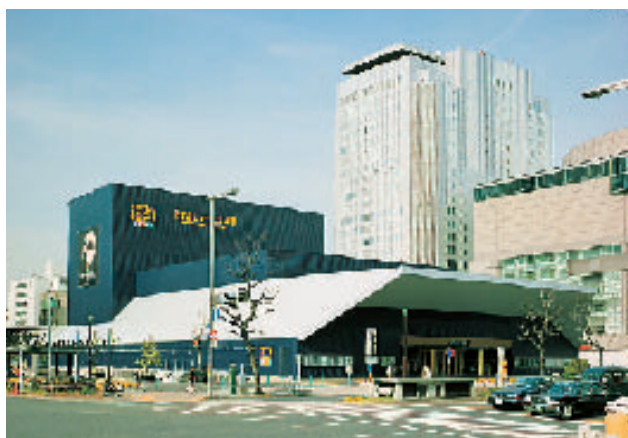
名古屋ミュージカル劇場。ワイヤレスマイクなどへの干渉障害を引き起こす電波侵入を防止するため電磁シールド材で覆っています。
