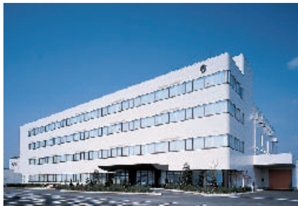
東京エレクトロン（株）の新プロセステクノロジーセンター。「クリーンルームにおける化学汚染制御技術の開発」で、第38回空調和・衛生工学会賞・技術賞を東京エレクトロン（株）と共同受賞しました。
