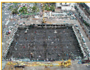
静岡駅前地下駐車場躯体構築工事 (静岡県静岡市)
