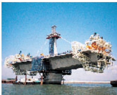
第二名神高速道路揖斐川橋西工事 (三重県四日市市)
