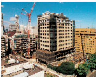
横浜地方・簡易裁判所建築工事 (神奈川県横浜市)
