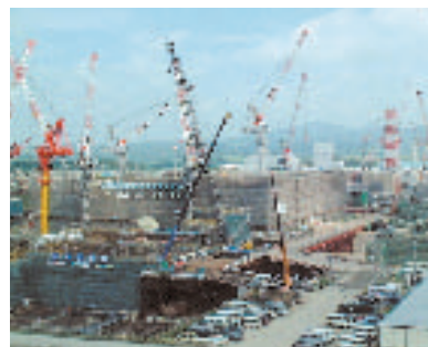
六ヶ所前処理建屋新設工事 (青森県上北郡)
