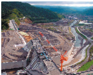
忠別ダムコンクリート・フィル堤体 建設工事 (北海道上川郡)
