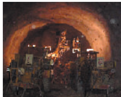
インダス高速道路 コハット工区建設工事 (パキスタン)
