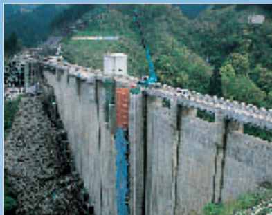
田沢川ダム建設工事 (山形県飽海郡)
