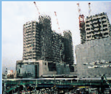
西宮北口駅北東地区再開発 西棟建設工事 (兵庫県西宮市)
