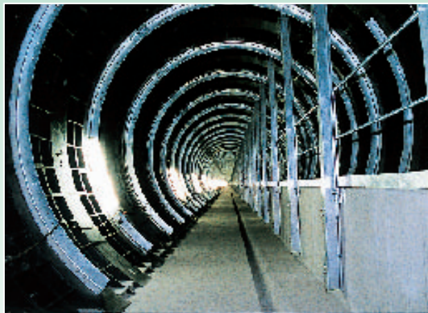
23号川越共同溝シールド (三重県三重郡)
