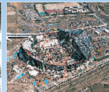
仮称豊田市スタジアム (愛知県豊田市)
