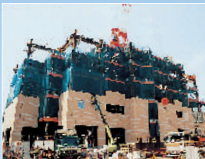
東五反田二丁目第1地区再開発 〔業務棟工区〕 (東京都品川区)
