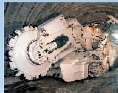
高取山工区(北行)トンネル工事 (兵庫県神戸市)
