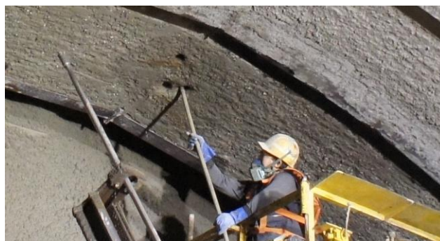
写真-3 モルタルの充填 Photo.3 Mortar injection
