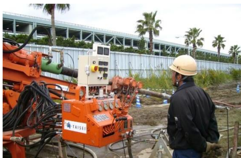
写真-2 施工中の状況
