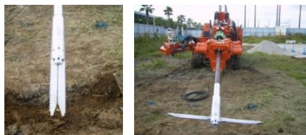
写真-1 地中拡翼型の攪拌装置
