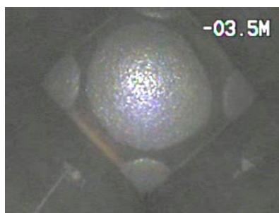
写真7 小型カメラで撮影した鋼管内の上昇状況 Photo.7 Situation in steel tube photoed with small camera
