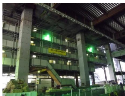
写真-11 超高強度 CFT 柱 Photo.11 High strength CFT columns
