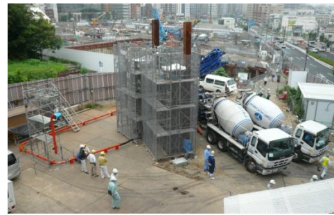
写真-1 圧入試験状況の一例 Photo.1 Example of pump up confirmation test
