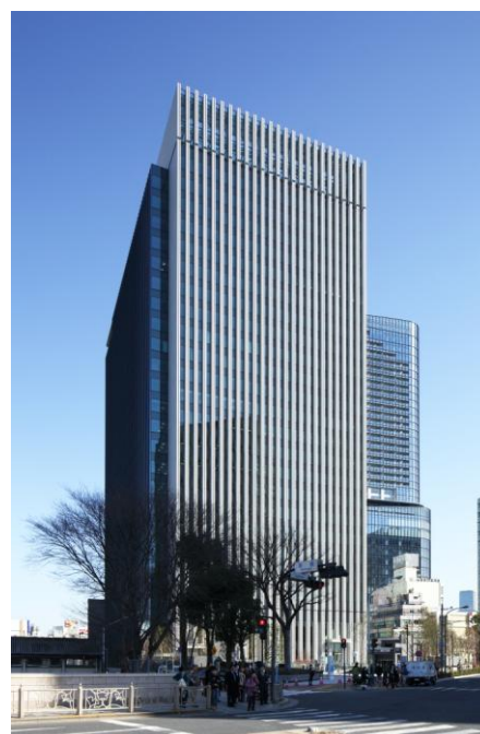
写真-1 建築物外観
