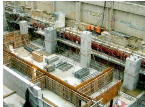
写真-3 下階 RC 造柱(PCa 柱)の建込み Photo.3 Erection of RC lower column
