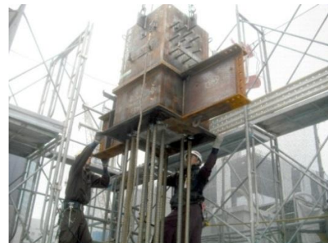
写真-4 上階 CFT 柱とパネル部の落とし込み Photo.4 Setting down of upper CFT column and panel
