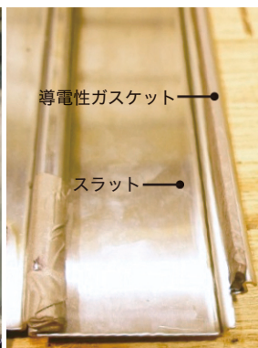
スラットの電磁シールド処理
