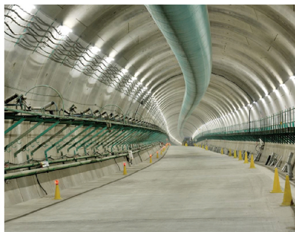
シールドトンネル坑内（道路床版施工後）
