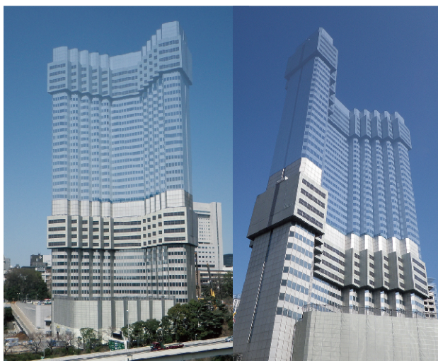
解体工事実施中の建物高さの変化
