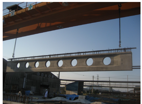
写真-3 PCaPC 梁(T-POP) Photo 3 PCa PC beam (T-POP)
