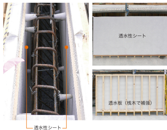
型枠の組立て状況
