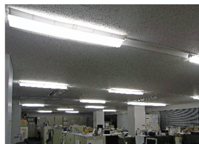
拡散カバーを設置した執務室の状況
