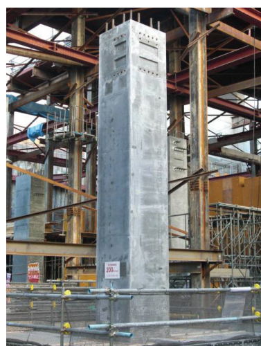
写真-5 プレキャスト柱の設置状況
