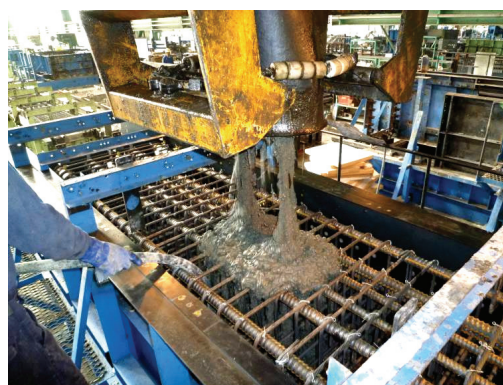
写真-3 コンクリートの打込み状況 Photo 3 Concrete placing in horizontal position
