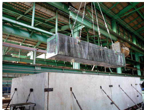
写真-4 ラップフィルム被覆を施したプレキャスト柱
