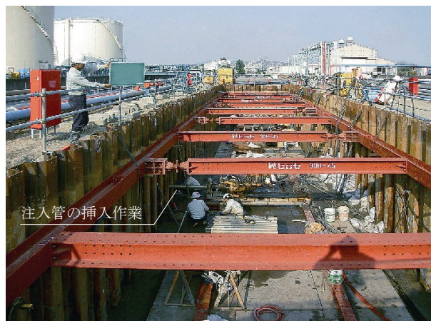
図一13 注入管の設置 (左: 立坑からの水平直線削孔, 右: グランドフレックスモール工法)
