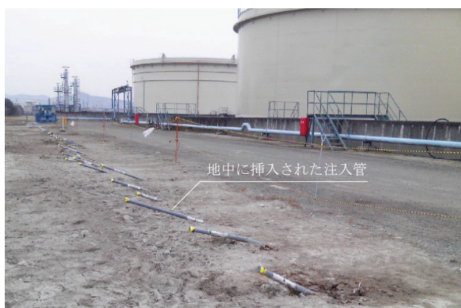
図一13 注入管の設置 (左: 立坑からの水平直線削孔, 右: グランドフレックスモール工法)
