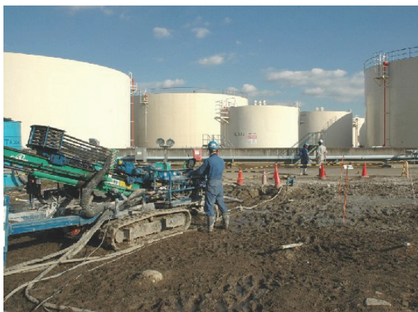
図一10 施工状況
