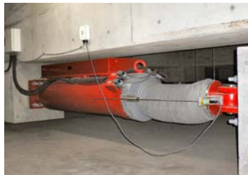
写真－7 可変減衰ダンパー Photo 7 Variable oil damper
