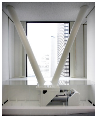
写真－2 ダンパー Photo 2 Oil damper
