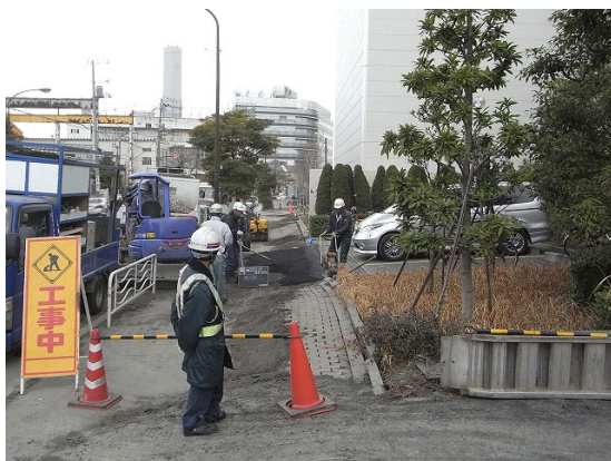
写真－２ 新木場地区における歩道の液状化被害 Photo 2 Damage of sidewalk in Shinkiba
