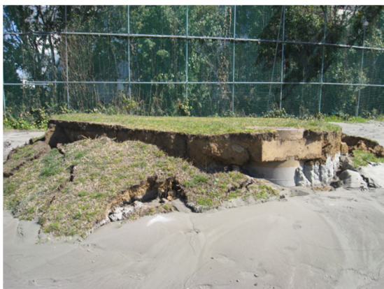
写真－３ 新木場地区における地中構造部の浮上 Photo 3 Uplifted tank in Shinkiba
