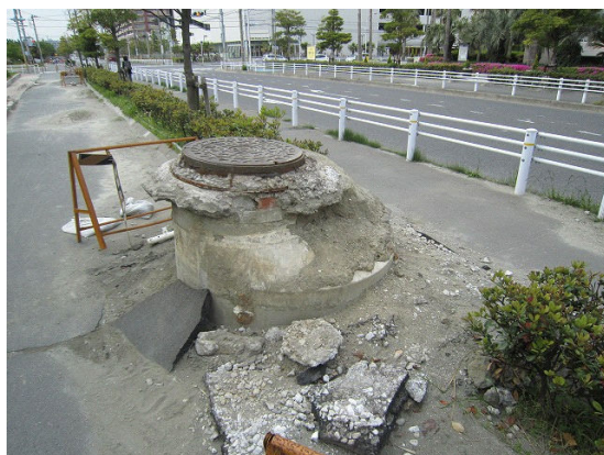
写真－５ 新浦安地区におけるマンホールの浮上 Photo 5 Uplifted manhole in Shinurayasu
