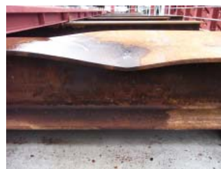
(c) 根太損傷状況 1
