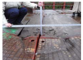
(b) 覆工板損傷状況 2
