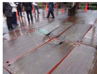
(a) 覆工板損傷状況 1
