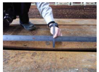
(d) 根太損傷状況 2
